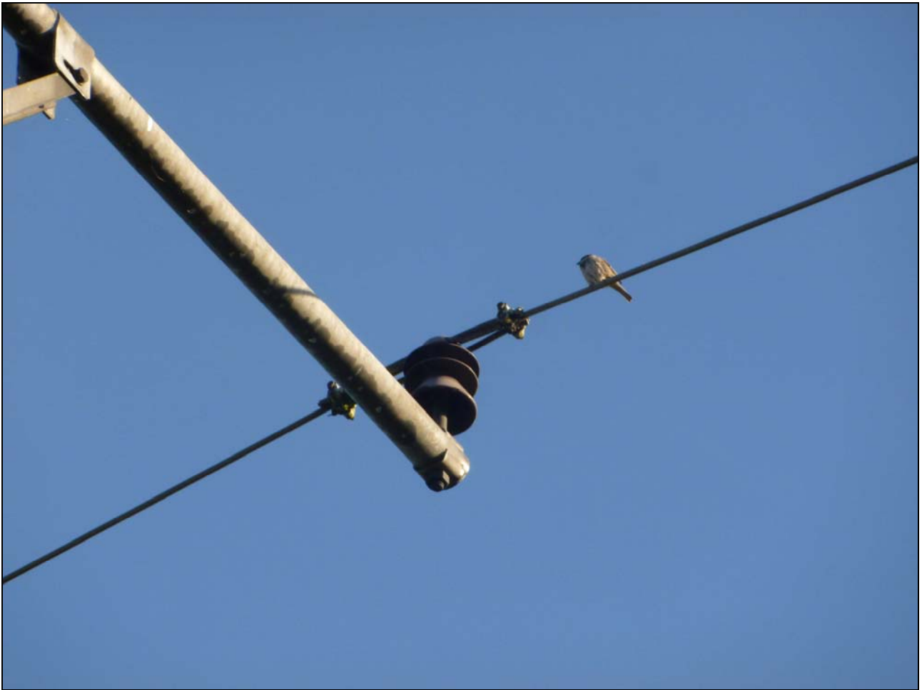
Abb. 2: Feldsperling am Brutplatz im Querrohr der Mittelspannungsleitung
