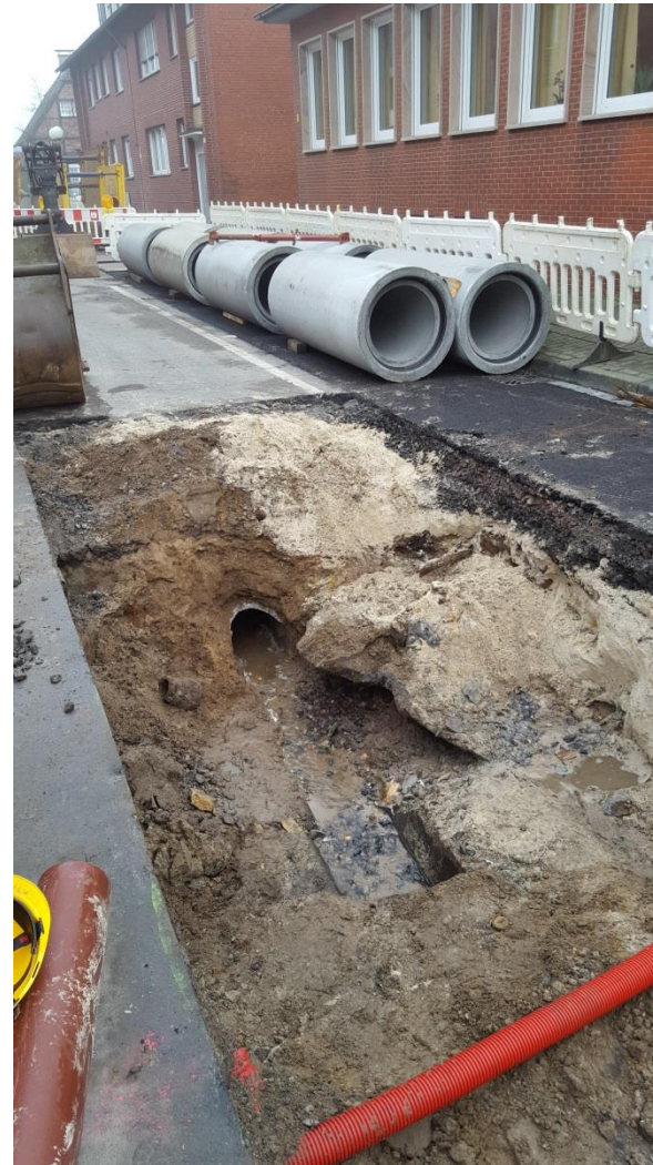
Ertüchtigung Regenwasserkanal Münsterstraße 2018
