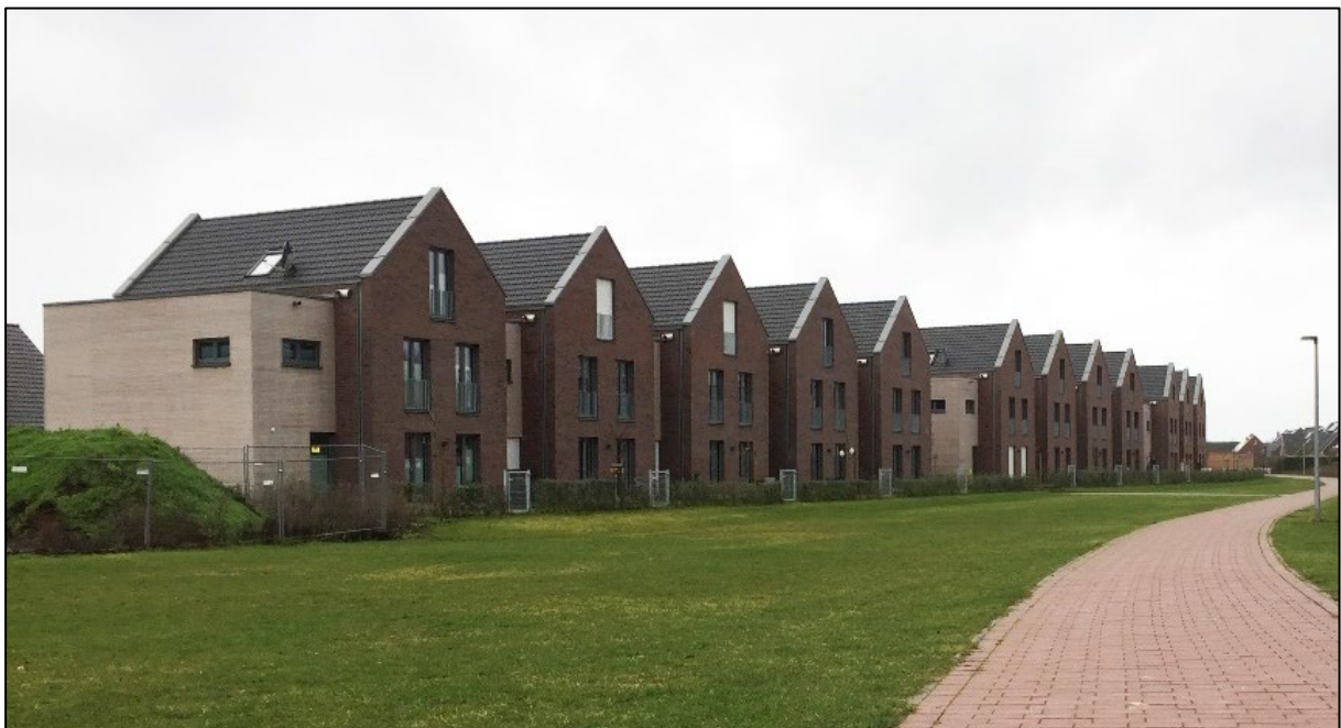
Abbildung 6: Beispiel für Rücksprünge des Hauptbaukörpers (Baugebiet Buskamp, eigene Aufnahme)
