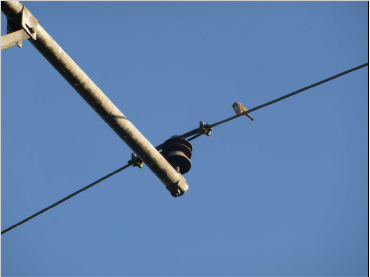
Abb. 2: Feldsperling am Brutplatz im Querrohr der Mittelspannungsleitung
