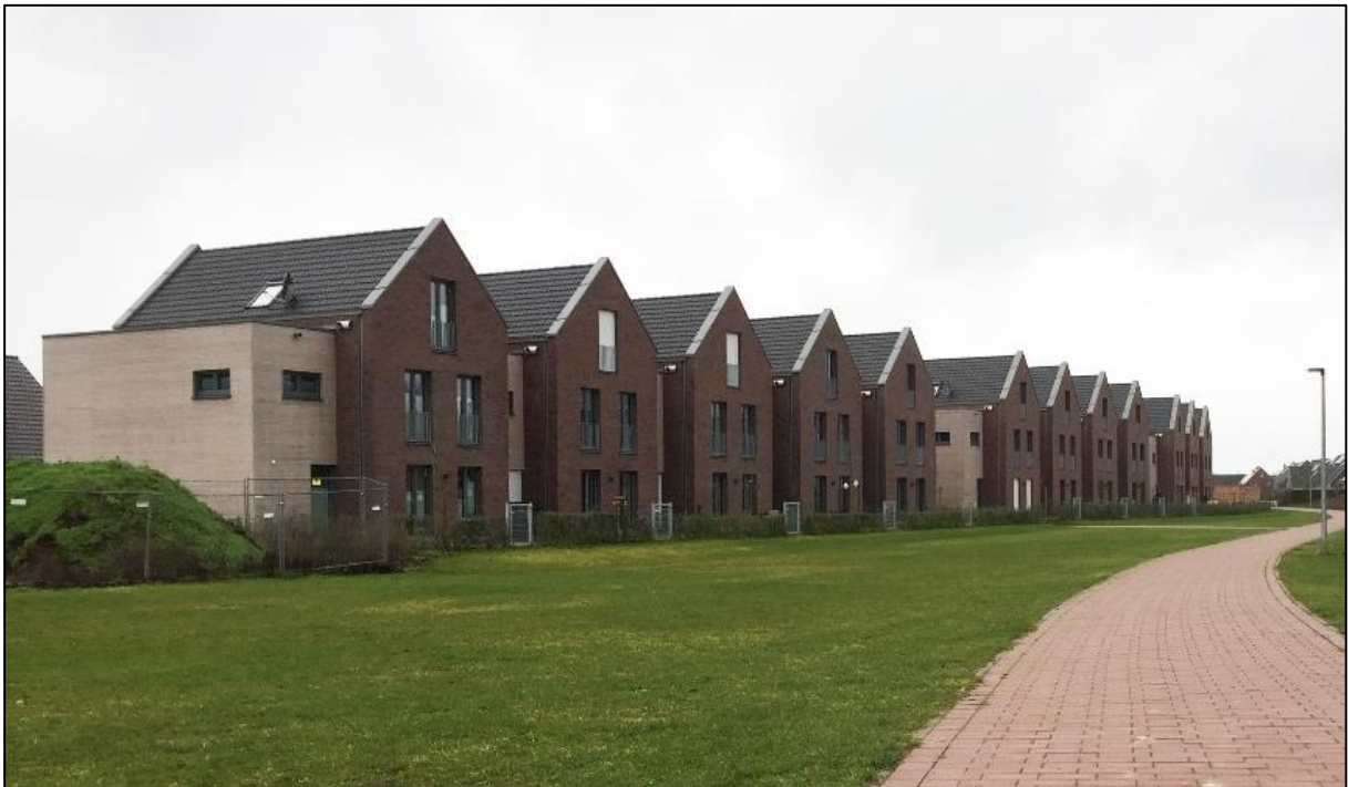
Abbildung 2: Beispiel für Rücksprünge des Hauptbaukörpers (Baugebiet Buskamp, eigene Aufnahme)
